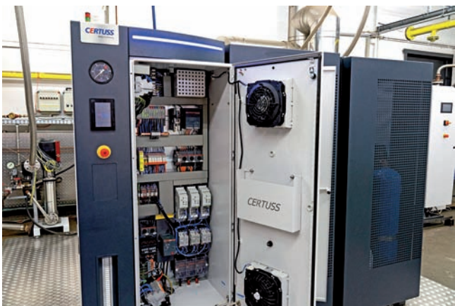
Ak proces vyžaduje viac pary, parné generátory EMX možno podľa potreby rozšíriť o ďalšie moduly.
